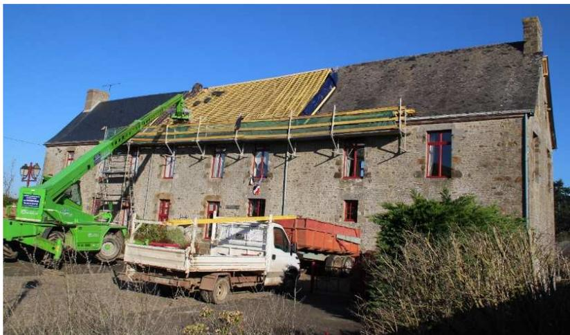
La charpente de ce bâtiment sera désormais totalement hors d'eau après la rénovation de sa couverture soit 514 m<sup>2</sup> de surface à traiter. Après plusieurs devis, la Sarl Gautier Didier a œuvré en ce sens avec l'intégration d'un velux de désenfumage au-dessus de l'escalier de la mairie dans le cadre du projet d'accessibilité future.
