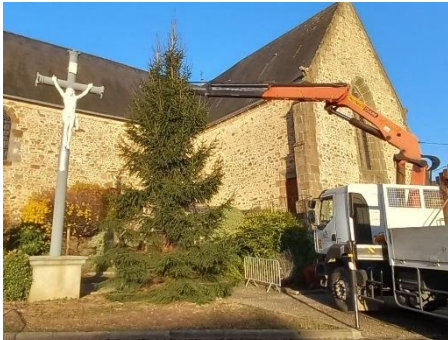
La mise en place du sapin s'est effectuée en douceur.
